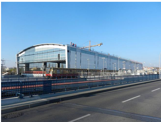
Neubau der Kynastbrücke ohne Radweg
